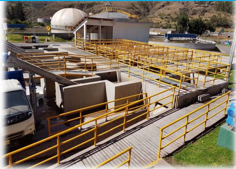
Sedimentador primario PTAR SEDACUSCO
