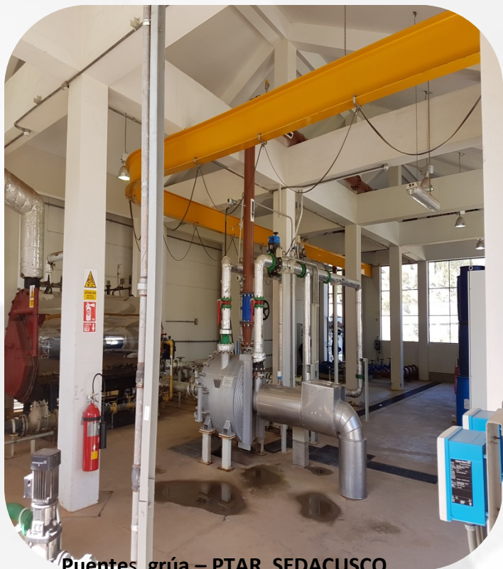
Puentes grúa - PTAR SEDACUSCO
